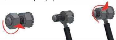
Conexión del equipo a una instalación equipotencial.
